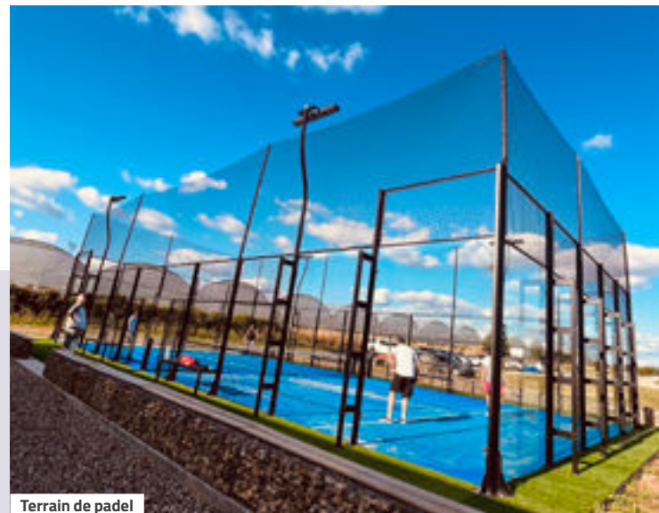
Terrain de padel
